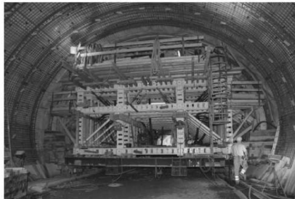
Szalunek samojezdny systemu NOETec w pozycji betonowania.
