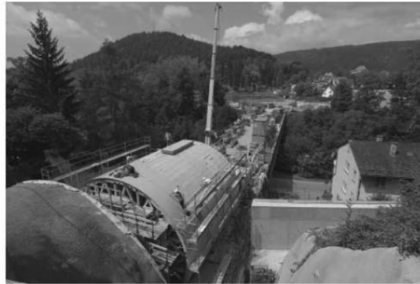
Montaż poszycia na samojezdnym szalunku systemu NOETec.
